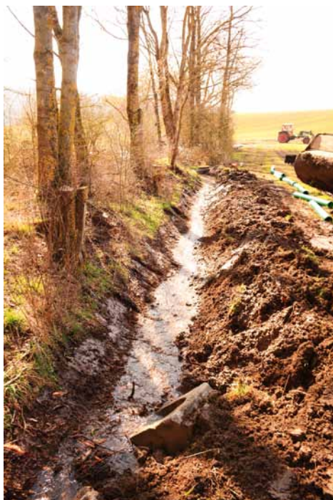
Dank des neuen Wasserzulaufs ist das Rossbrünnele wieder zuverlässig mit Wasser versorgt. (Foto: Marion Betz)
