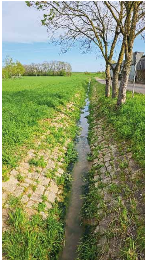
Der Rippach bei Gelchsheim mit direkter Einleitung der gepflasterten Straßengraben. (Foto: Christine Primbs)
