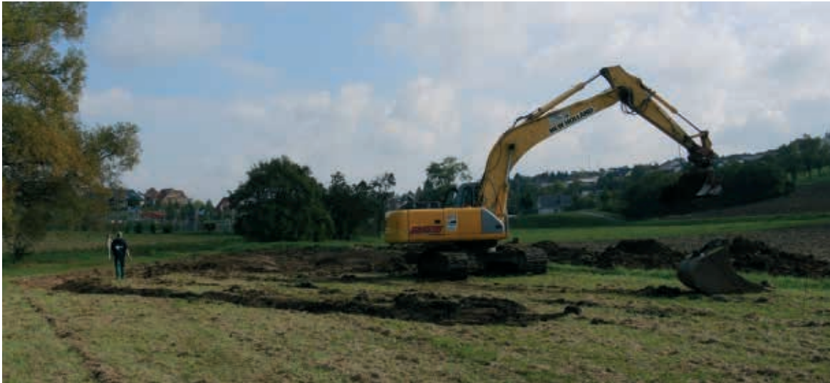
Beginn der Bauarbeiten am 23. September 2013 auf der unteren Wiese
