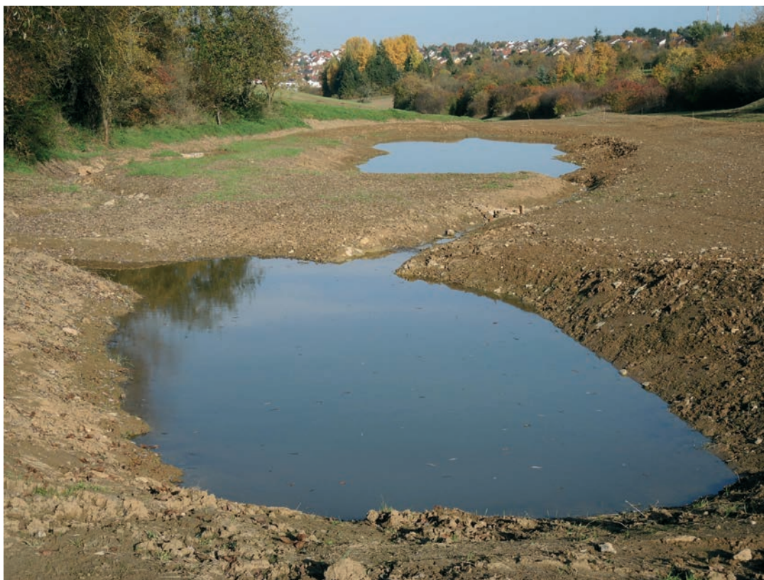
Fertiggestellte Rückhaltebecken im oberen Teil, 22. Oktober 2013
