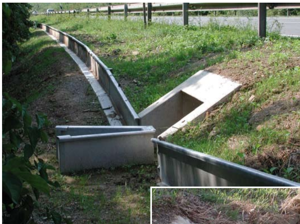
Krötentunnel und Leitsystem
